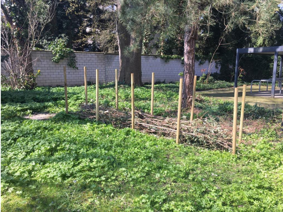
Abbildung 3: Bau der Totholzhecke
